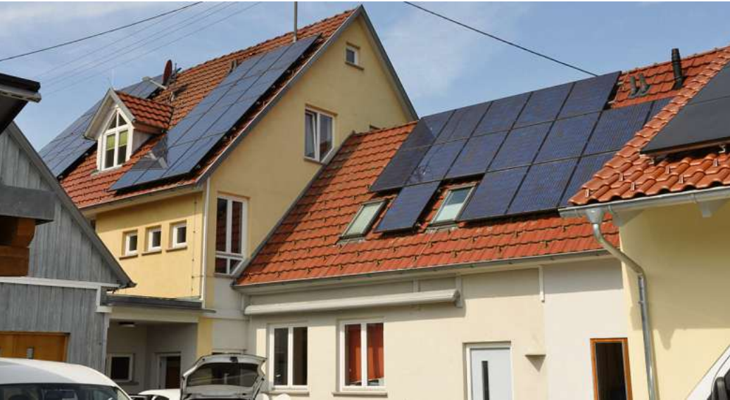
Mit der PV-Anlage auf dem Dach der Sozialstation St. Franziskus werden die Autos fürs Pflegepersonal geladen.
